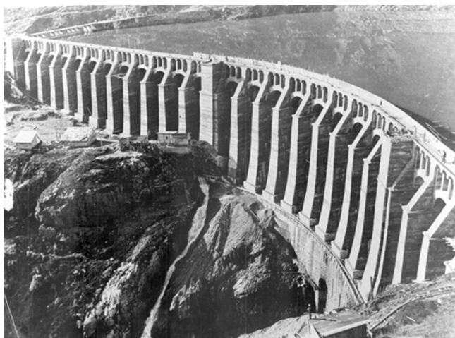
Diga terminata nell'ottobre 1923 (foto d'archivio)
