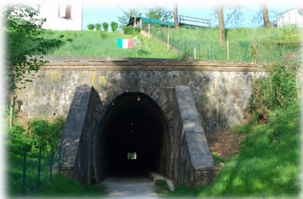
Galleria della Morla ex ferrovia V.B.
